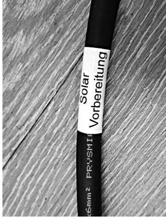
Kabel Vorbereitung Solaranlage
