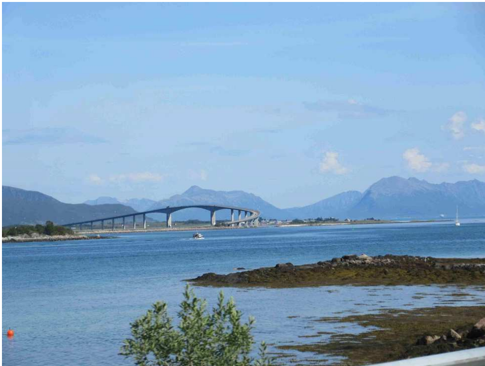
Brücke von STOKMARKNES
